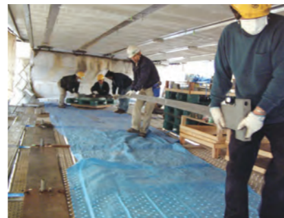
② 定着アンカー削孔
