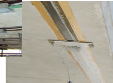
⑦ アウトプレート仕上げ塗装
