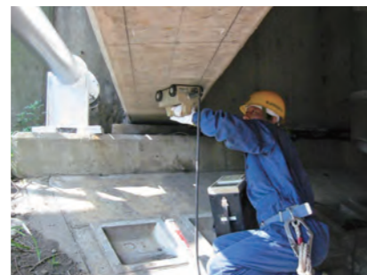
① 鉄筋探査
