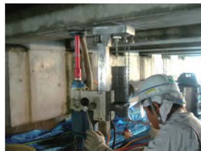
② 定着アンカー削孔
