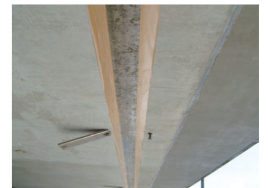
④ 接着面プライマー塗布
