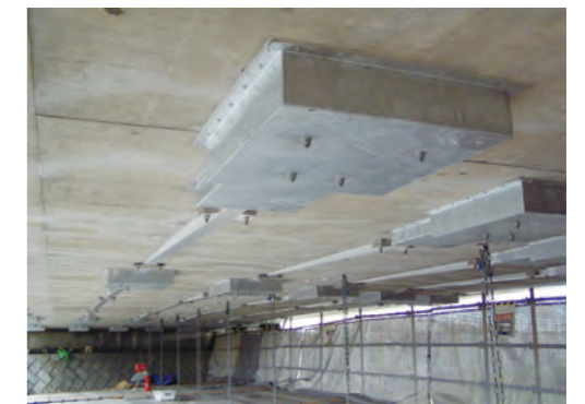
⑧ 定着部防錆処理
